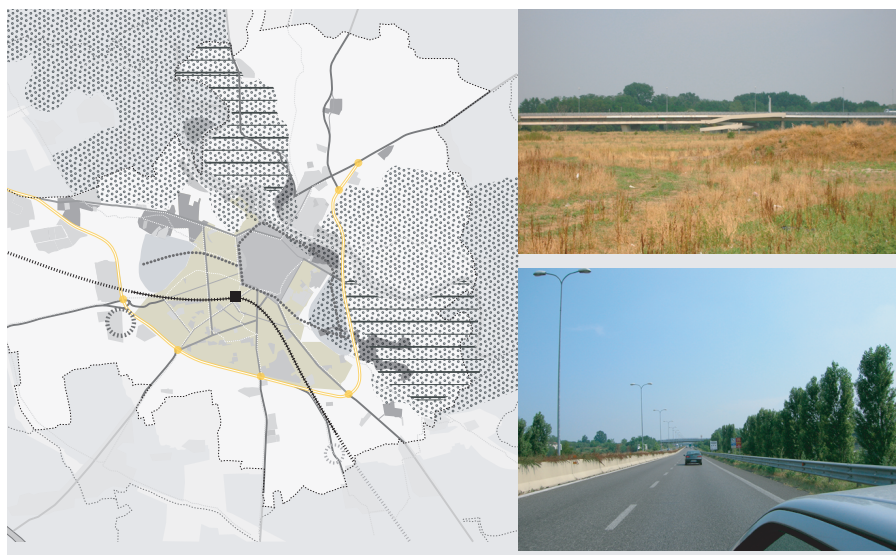
Le tangenziali Immagini delle tangenziali nel loro inserimento nel paesaggio agricolo della zona di Selvagreca (in alto) e gli ingressi all'infrastruttura (in basso).
